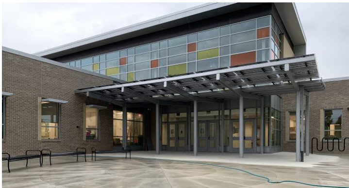
Graceland EM #240 - Replacement
