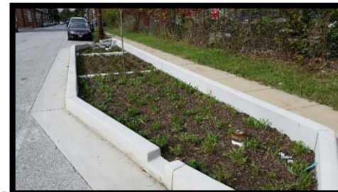
Curb Bumpout Bio-Retention (Bush St)
